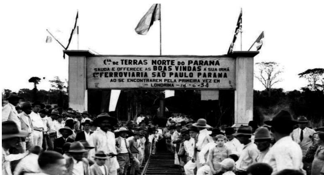
Figura 9: Inauguração da chegada da Estrada de Ferro em Londrina Fonte: Biblioteca Nacional, 2017.
