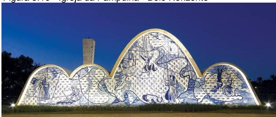
Figura 5.10 - Igreja da Pampulha - Belo Horizonte
