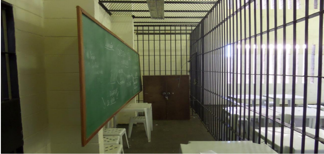
Imagem 5- Sala de aula 2016 – Canteiro de trabalho
