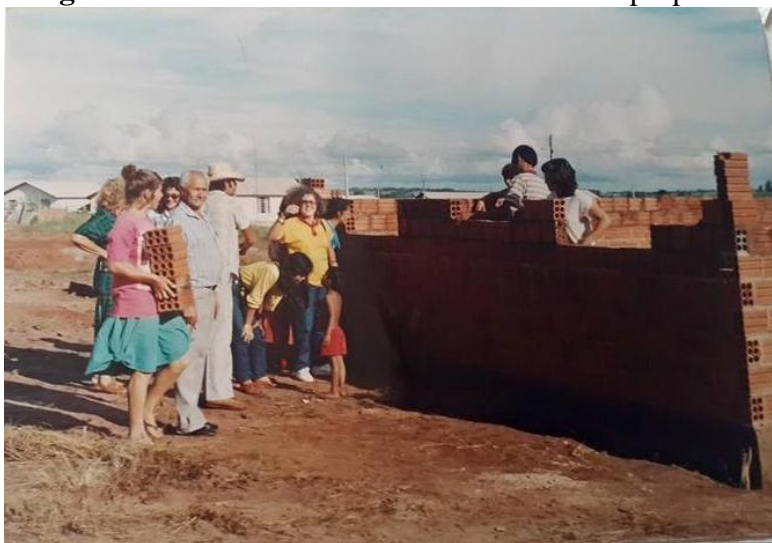
Imagem 19- Primeiras casas do mutirão da casa própria.
