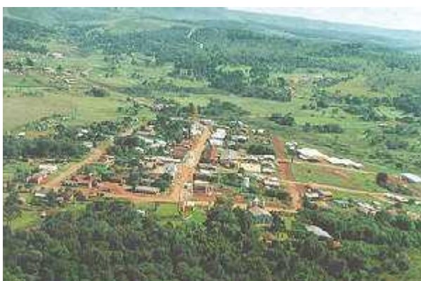
Foto 1 - Fonte: SEDU – PARANACIDADE.
