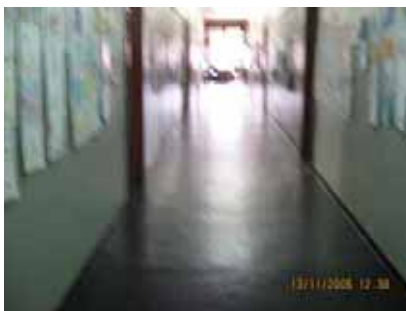
Figura 5 - Piso emborrachado (encontrado em corredores)
