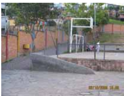
Figura 6 - Piso cimentado (encontrado em área externa)
