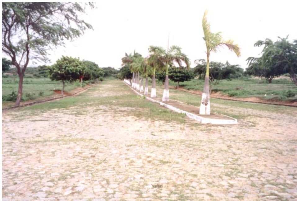
Foto 23 – Arruamento. Implantação de infra-estrutura de urbanização. Loteamento localizado nas imediações do Rio Cocó, sobre o tabuleiro, supostamente associado às propriedades do grupo M. Dias Branco na área. O acesso tornou-se possível pelo prolongamento da Av. Pe. Ant.º Tomás a partir da Cidade 2.000 e também pela Av. Santos Dumont.
