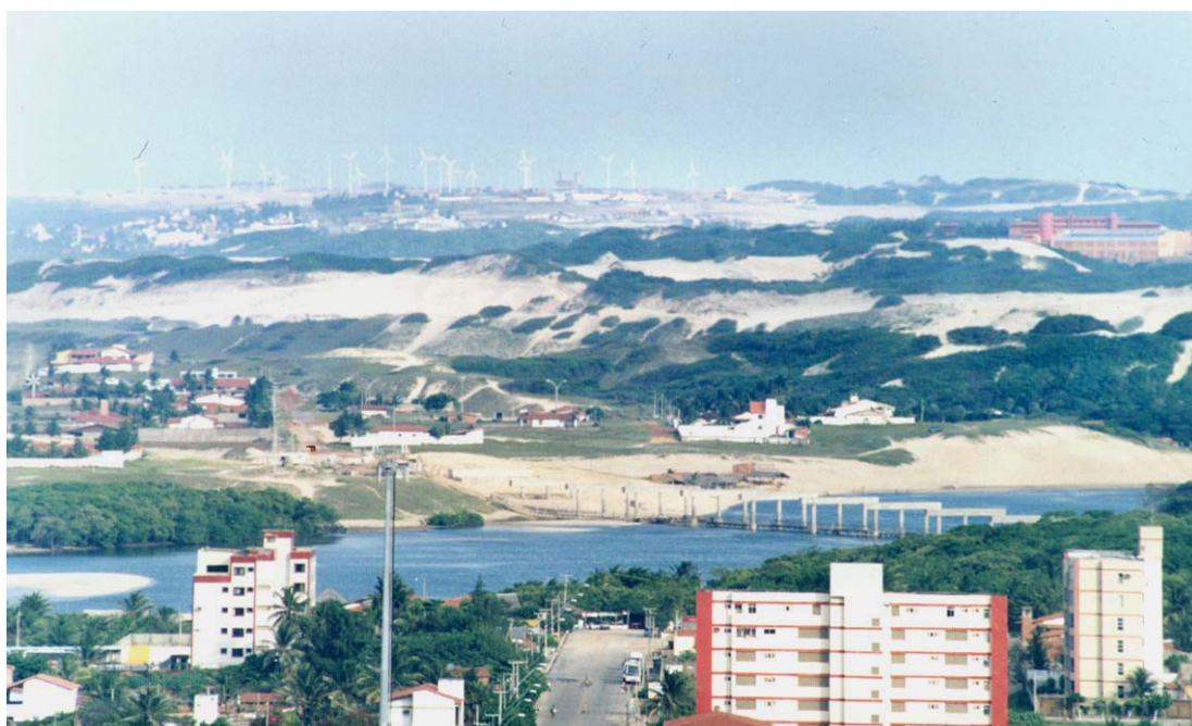
Foto 20 – Final sem saída da Av. Dioguinho. Estrutura inacabada da ponte sobre o Rio Cocó. O projeto atual prevê a implantação de 16 pilares de concreto, 12 dos quais no leito do rio, capazes de impactar a dinâmica de sedimentos em trânsito no estuário. No horizonte, parque eólico localizado na Prainha (Município de Aquiraz), instalado e operante a partir de 2001, interfere na paisagem de forma a aproveitar a passagem dos ventos Leste-Sudeste em direção a Fortaleza.
