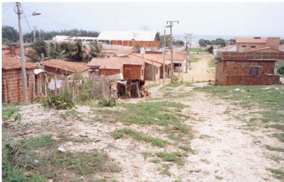
Foto 12 – Uma das favelas nas imediações da praia do Caça e Pesca. Impactos sócio-ambientais de elevada magnitude, com o lançamento de efluentes domésticos a céu aberto.
