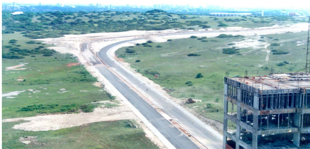
Foto 19 – Traçado asfaltado do prolongamento da Av. Pe. Antônio Tomás sobre o tabuleiro e campo de dunas. Em primeiro plano, a construção de mais uma torre de flats (a terceira, também prevista para 22 andares), na esquina da Av. Dioguinho com o novo acesso à Cidade 2.000 e Aldeota.
