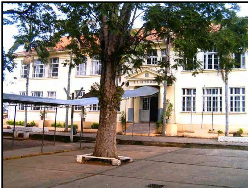
FIGURA 3 – Vista parcial da Escola Estadual Estado de Goiás. Arquivo Ani - 2004
