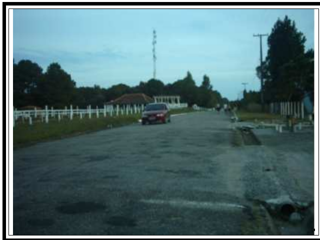
FIGURA 12 - ESTRADA DE ACESSO AO PARQUE COM A RAIA AO LADO
