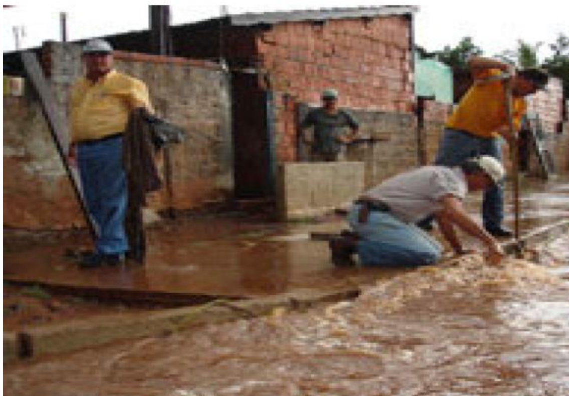
Figura 30 – Fonte 05 - Bueiro entupido, causando problemas em dias de chuva. Num único dia choveu 102 milímetros, a água chegou a medir 1,20 metros dentro de uma residência, segundo depoimento de um aluno. Foto: Pimenta, Março de 2005.
