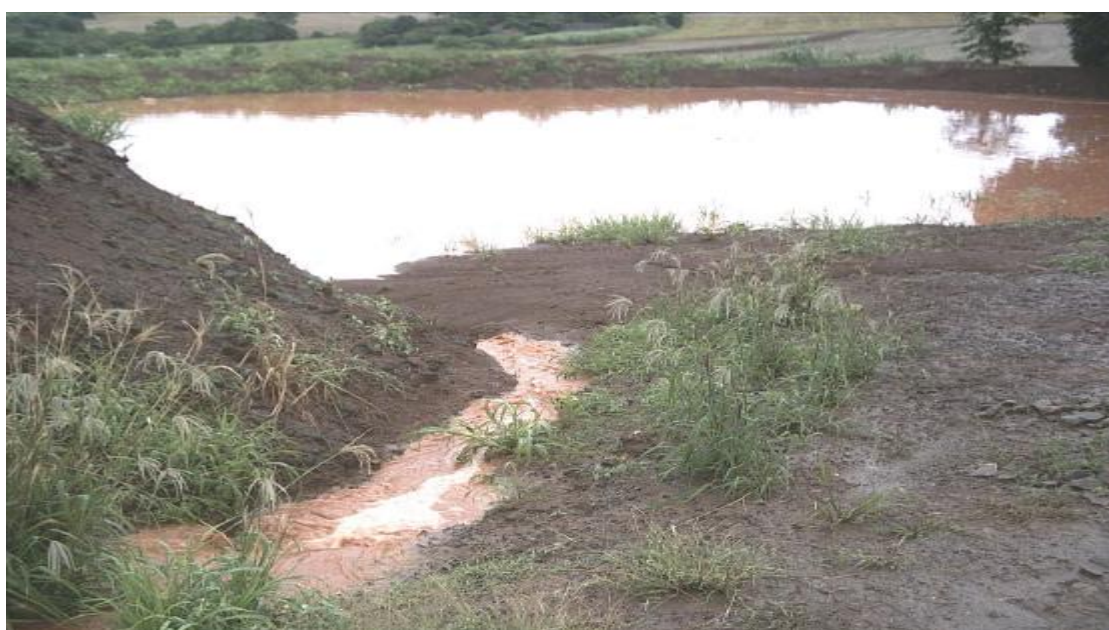
Figura 36 – Fonte 10 - Lagoa de contenção na margem de estrada rural, com capacidade aproximada 1800m 3 . Foto: Pimenta, Março de 2006.
