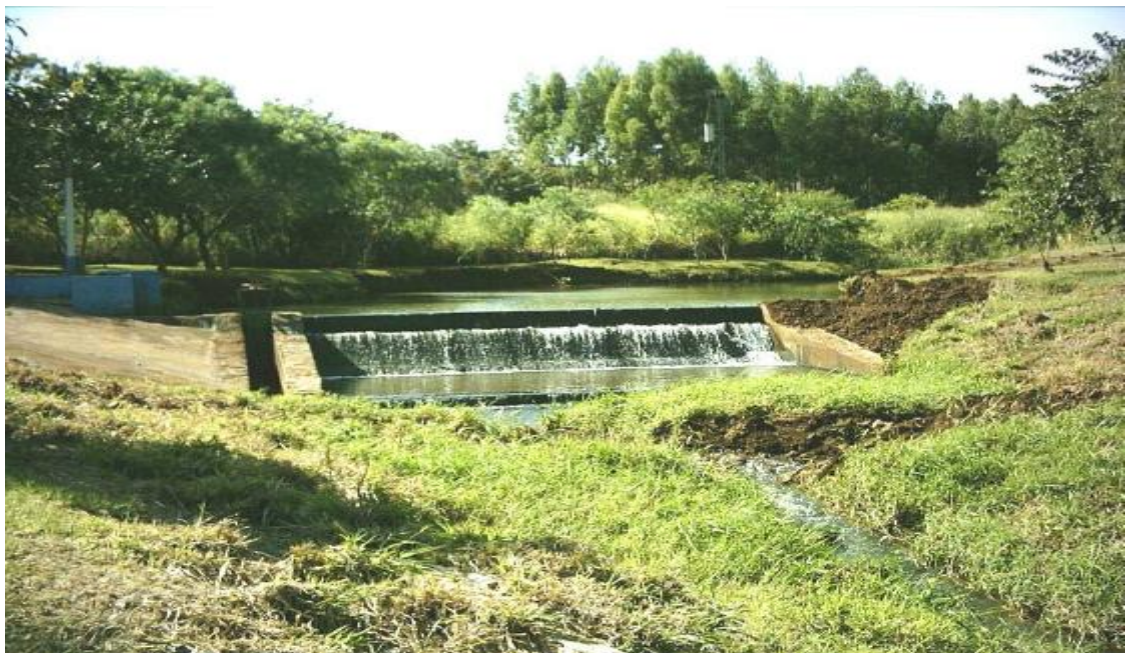
Figura 40 – Fonte 13 - Estação de captação de água da SANEPAR, chamando atenção pela falta de mata ciliar. Foto: Pimenta, 2006.
