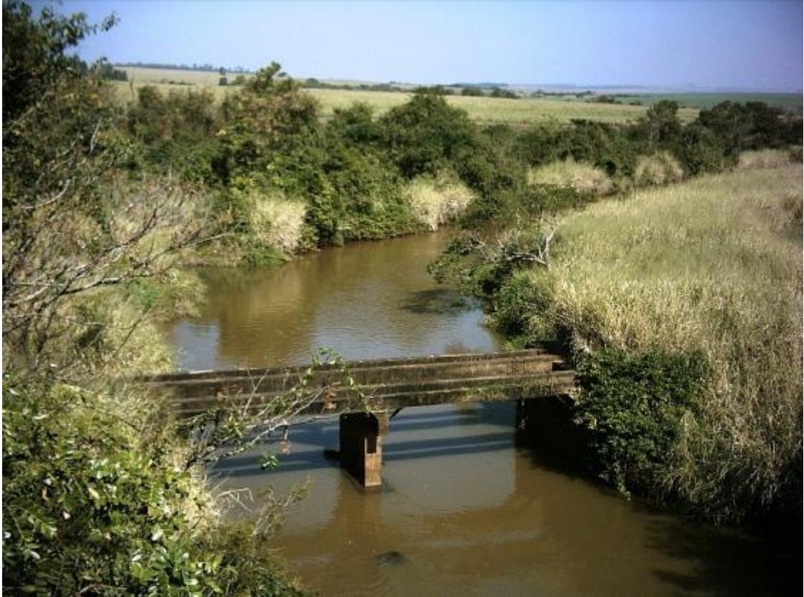
Figura 44 – Fonte 17 - Ausência de mata ciliar no Ribeirão Vermelho na área de confluência do Córrego Minas com o Ribeirão Vermelho. Foto: Pimenta, Março de 2006.
