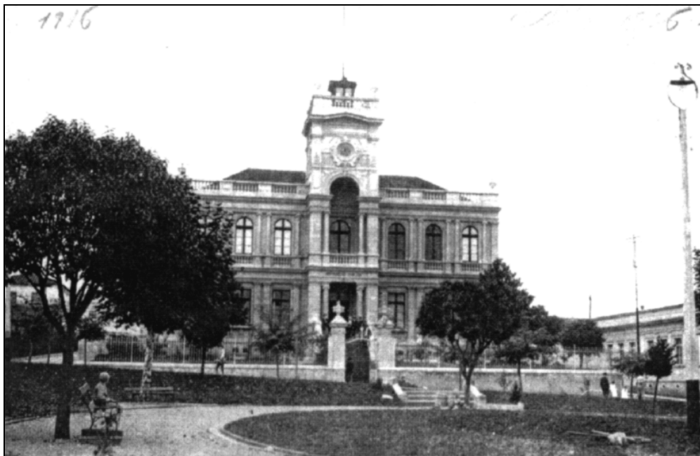
FIGURA 1 – ANTIGO PRÉDIO DA ESCOLA NORMAL (c) 1916. Arquivo: Casa da Memória
