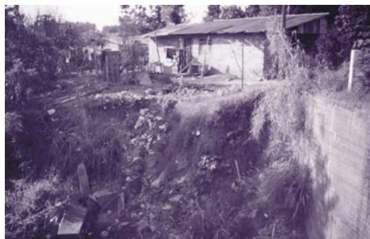
Figura 2. Margem do córrego Ribeirão do Pinhalzinho (Umuarama, Paraná, Brasil) demonstrando sua degradação, quase ausência de mata ciliar e casebres à beira da passagem fluvial. Notar a quantidade de lixo urbano.
