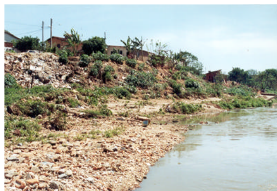
Figura 3 – Assoreamento do córrego Cascável
