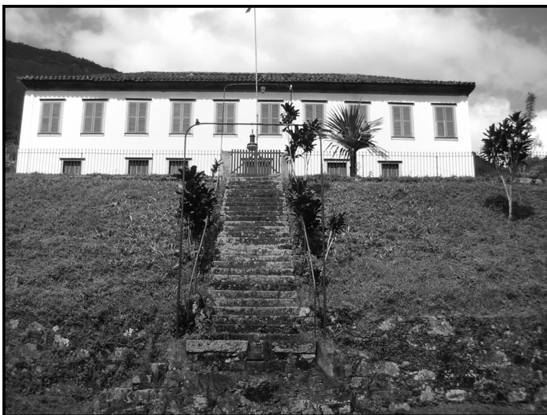
Casa de vivenda da fazenda Santo Inácio – vista do terreiro
