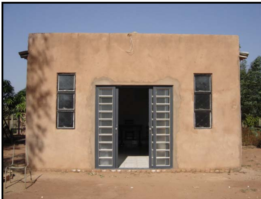
Figura 13. Foto da vista externa da capela construída no lote da Sra. M.C.S., assentamento São Bento setor I, 2005.
