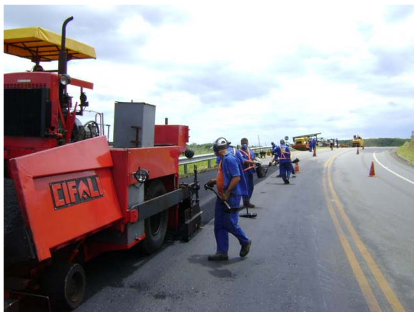
Foto 11: Vibro-acabadora espalhando o Asfalto Borracha .
