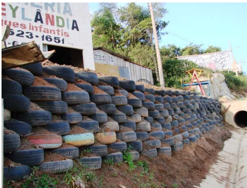
Foto 7: Pneus sendo usados como contenções de taludes.
