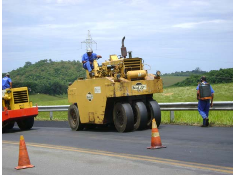
Foto12: Rolo Pneumático compactando a mistura.
