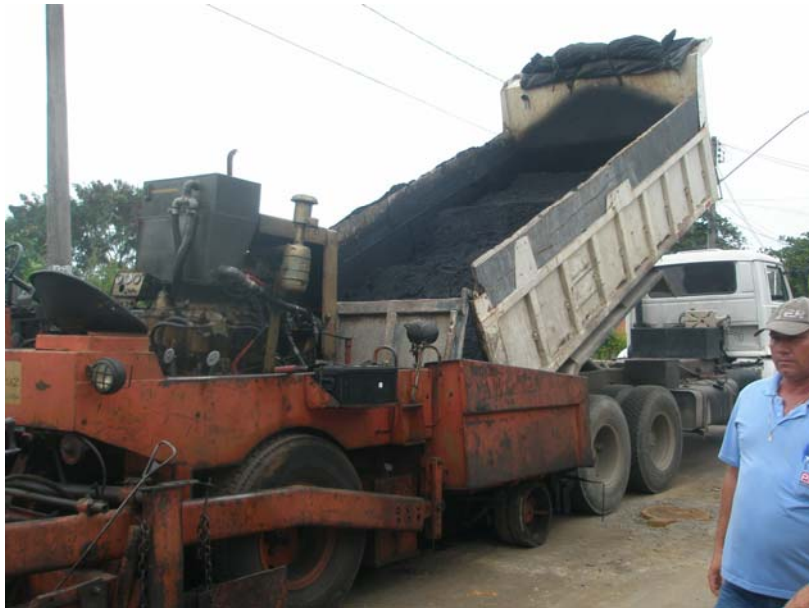
Foto 10: Vibro-acabadora de asfalto recebendo a mistura asfalto-borracha de um caminhão basculante
