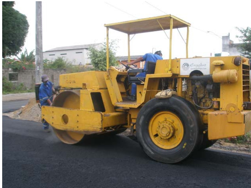
Foto 13: Rolo de chapa compactando e dando o acabamento final do Asfalto Borracha recém aplicado.
