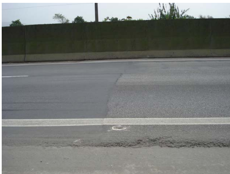
Foto 8: Emenda dos dois tipos de pavimentos (1) CBUQ – Convencional e (2) Modificado com Borracha de Pneus
