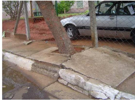
**Foto 2: Impedimentos à circulação de pedestres, cadeirantes e idosos nas calçadas do conjunto.**
