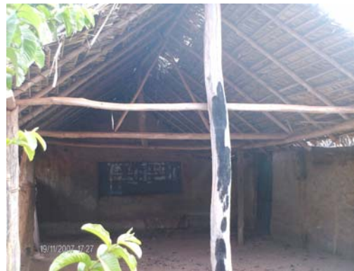
Figura 5.5 – Salão auxiliar da escola João M. de Sousa
