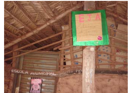
Figura 5.7 – Placa de identificação
