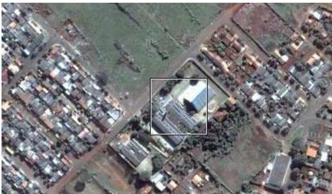
Figura 2 - Escola CAIC na área marcada (vista aérea)
